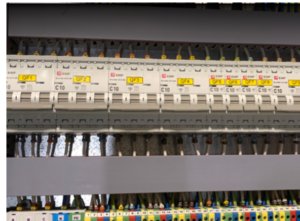
ВА 47-63N 6кА Автоматический выключатель
