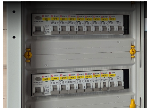
ВН-63N Выключатель нагрузки ВА 47-63N 6кА Автоматический выключатель ВД-100N Выключатели дифференциального тока АВДТ-63М Автоматический выключатель дифференциального тока
