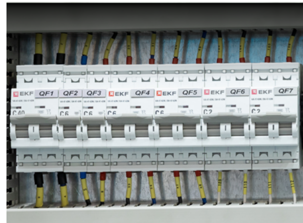
ВА 47-63N 6кА Автоматический выключатель
